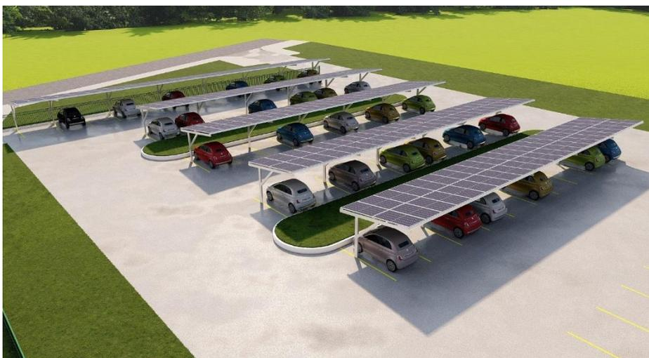
Imagem 15 - Modelo proposto para cobertura fotovoltaica do estacionamento de veículos oficiais.
